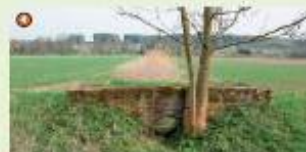
Nahoře: Lužní zarůstka, boční propustek do vedlejšího bočního náhonu. Dole: Akvadukt v místě křížení toku zivahové vody (nahorá) a Mlýnského náhonu (dole). Uměňují i přímý vodní potok s průchodem tří příse náhonu.
