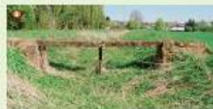
Hradec lukva na hlavním náhonu (zde se používala hradební příkra – velká tračička).
