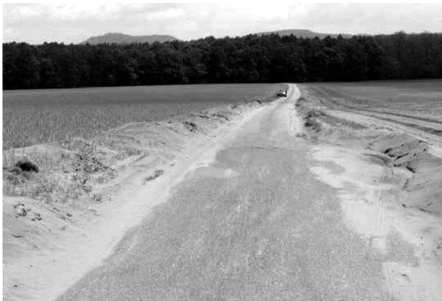
Zavátí komunikace u Nového Přerova. Foto SPÚ Břeclav
