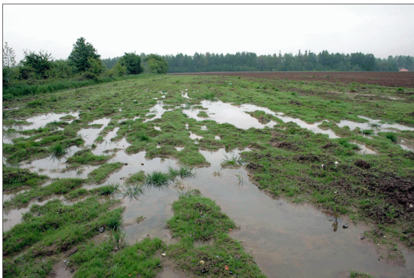
Obr. 2 Důsledek poškození drenážního systému, projevující se trvalým zamokřením pozemku a ve vodném období vývěrem vod na povrch území.
