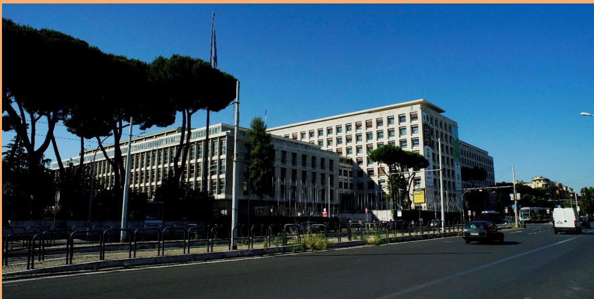
Obr. 1. Sídlo FAO v Římě
